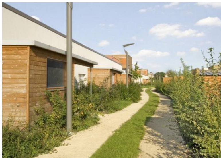
Mise en œuvre stabilisé
