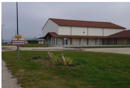
Absence de traitement de la frange urbaine sur la RD 473 en provenance de St-Donat-sur-l'Herbasse.
