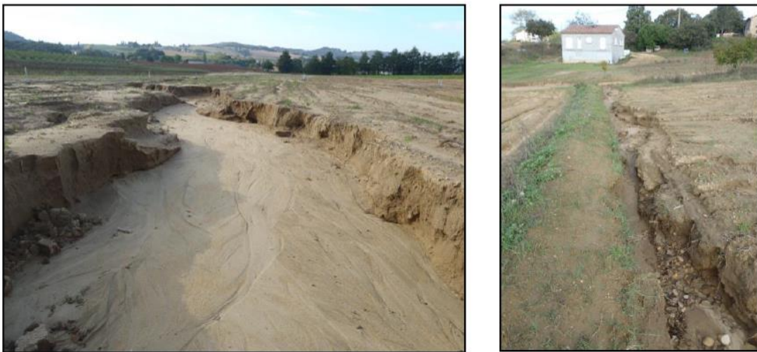
Aperçu des traces d'érosion engendrées par le système d'écoulement existant au lieudit le Fayet
