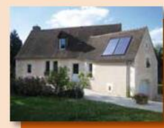
> Capteurs intégrés en toiture (CEST)
