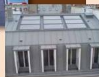
> Capteurs thermiques sur toiture zinc (Eau chaude solaire collective)
