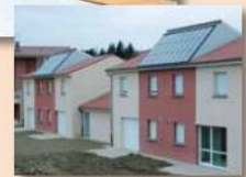
> Couverture totale en capteurs solaires thermiques (Chauffage)
