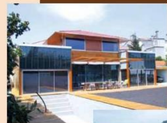
> Capteurs thermiques en façade (Chauffage)
