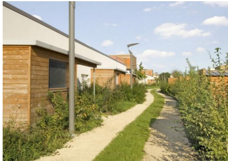
Mise en œuvre stabilisé
