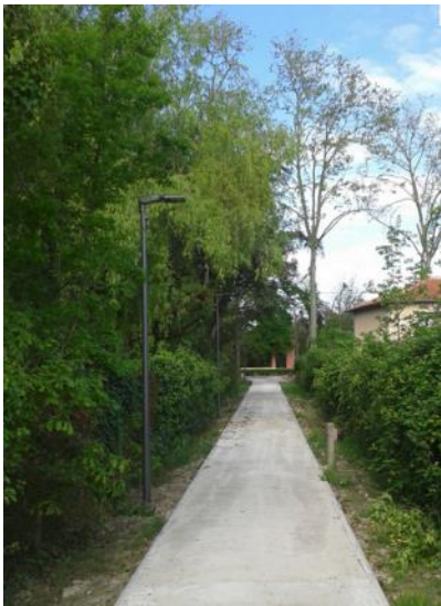
Mise en œuvre béton
