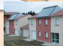
> Couverture totale en capteurs solaires thermiques (Chauffage)
