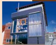
> Capteurs sous vide en façade
