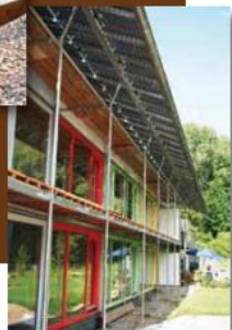
> Photovoltaïque en toiture avec auvent
