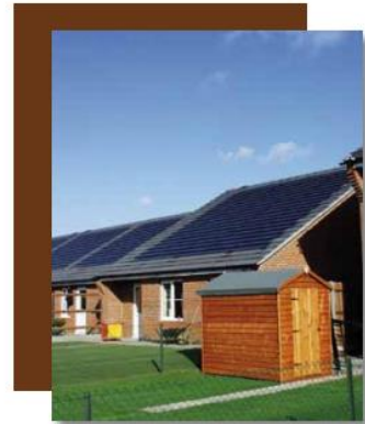
> Intégration photovoltaïque en toiture
