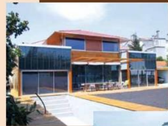
> Capteurs thermiques en façade (Chauffage)
