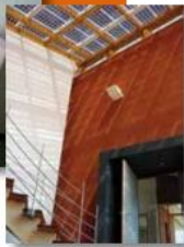
> Capteurs photovoltaïques semi-transparents en verrière
