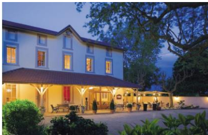
Auberge du Pont du Chalon
